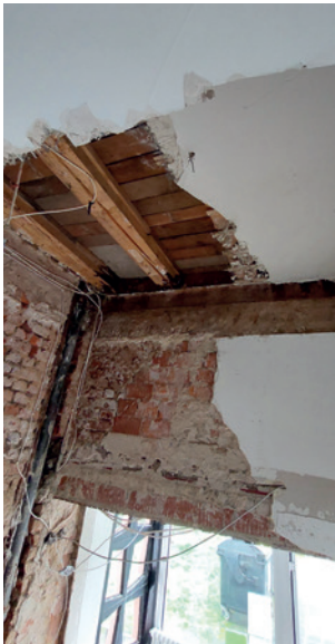
Alte Ziegel, Gußeisenrohre und Holzdecke kommen bei der Sanierung zum Vorschein ...
