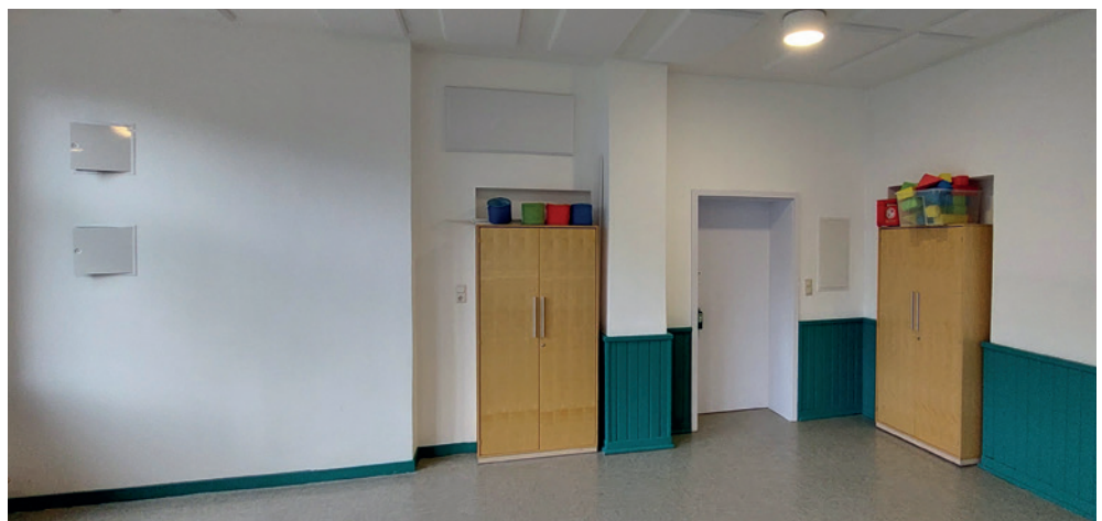
So strahlt der sanierte Raum. Links sollen Revisionsklappen zukünftig erleichtern, den Zustand der Rohre zu begutachten. Die Holzverkleidung wurde farbig
